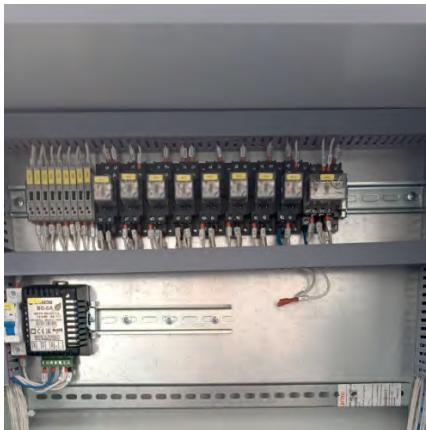
Шкаф автоматического управления резервом (ШАУР), или автоматический ввод резерва (АВР), предназначен для обеспечения перехода электропитания с внешнего источника (сеть) на собственный источник и перехода на основной источник питания при восстановлении его работы.
